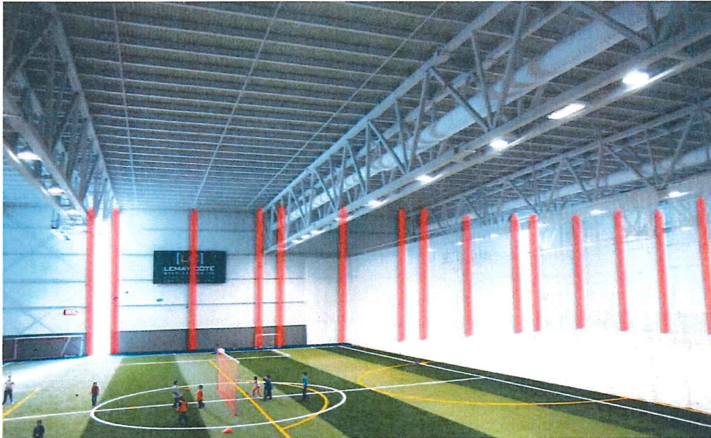
Fig. 18 – Colonnes d’acier en périphérie du bâtiment (Infographie ABCP sur photographie représentative du Complexe Victoriaville)
