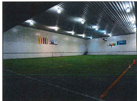
Structure monocoque de type « HONCO » (Centre Multisport de Rosemère – TX-36)
