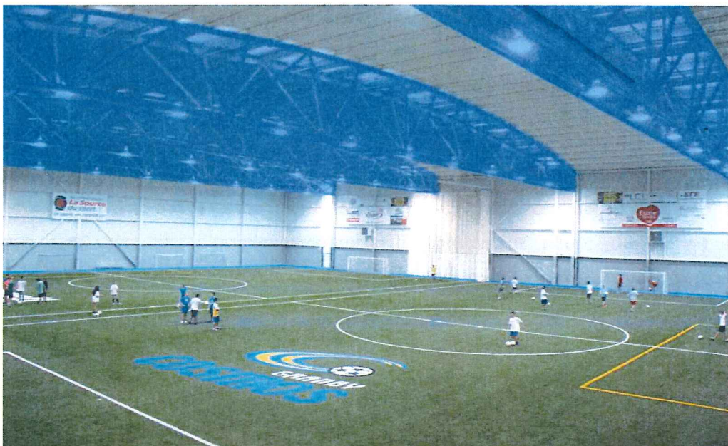
Fig. 19 – Fermes maitresses triangulées supportant des membrures en porte-à-faux (Infographie ABCP sur photographie représentative du Complexe Artopex)
