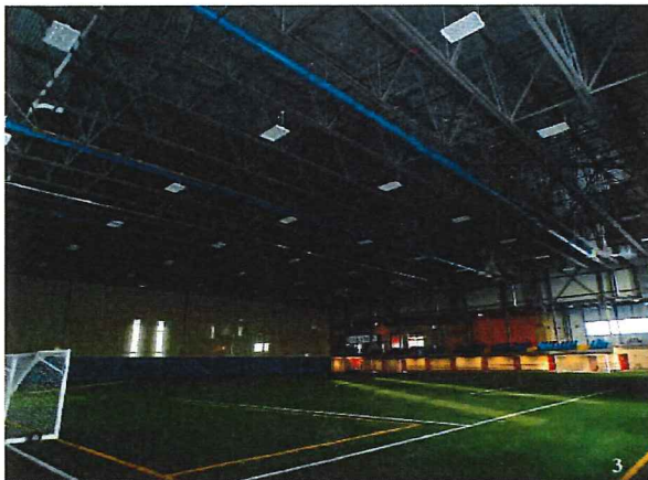
Structure conventionnelle de poutrelles ajourées de type « CANAM » (Centre de Soccer de Terrebonne – TX-35)
