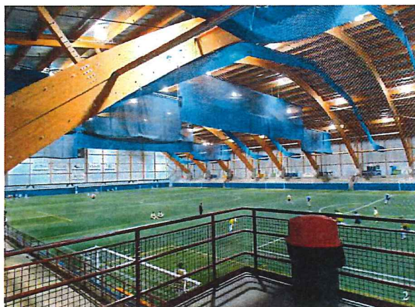
Structure en bois (Complexe Multisport de Laval – TX-37)
