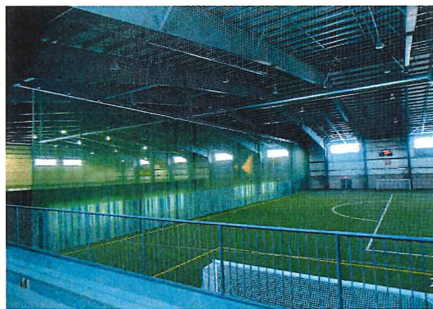
Structure arquée de type « STEELWAY » (Complexe Multisport St-Eustache – TX-38)
