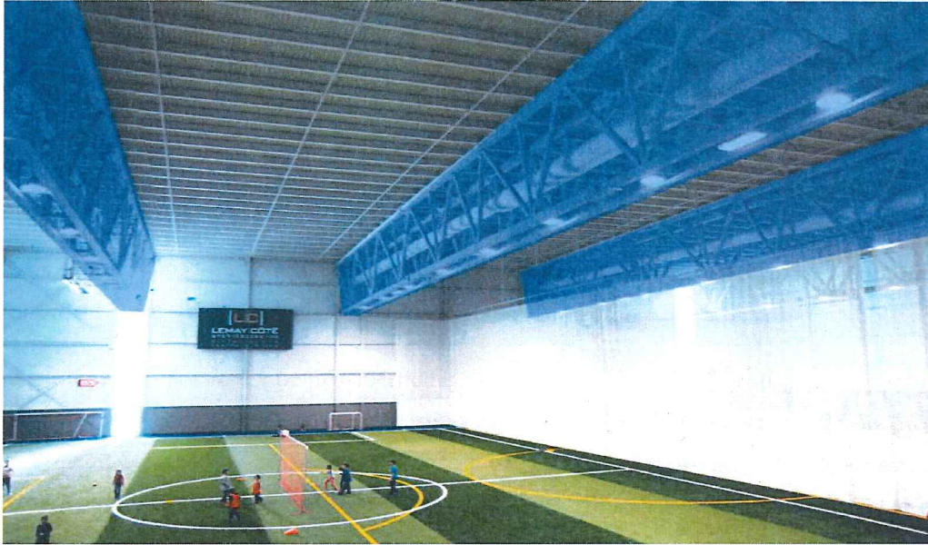
Fig. 20 – Fermes maitresses triangulées supportant des membrures en porte-à-faux (Infographie ABCP sur photographie représentative du Complexe Victoriaville)
