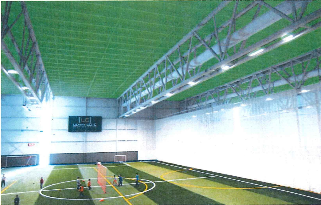
Fig. 23 – Membrures secondaires fixées aux membrures en porte-à-faux et pontage de toiture (Infographie ABCP sur photographie représentative du Complexe Victoriaville)
